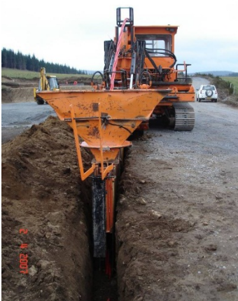
Figure 11 : Réalisation de la tranchée et de la pose du câble simultanément
