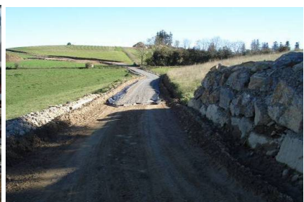
Mise en place du gravier
