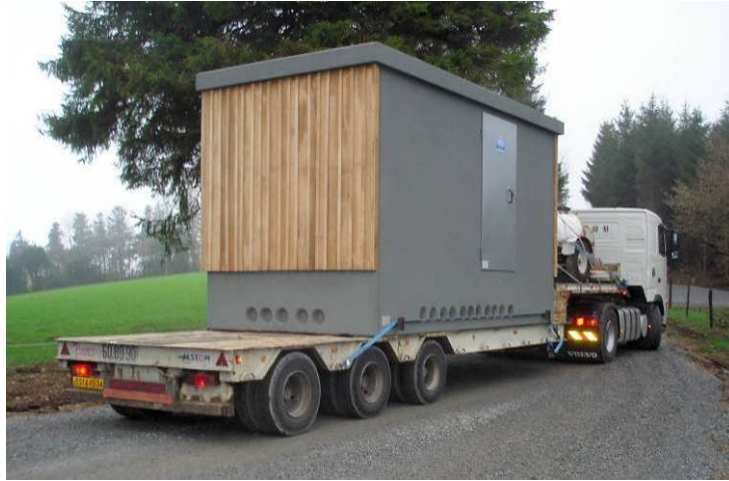
Figure 7 : Arrivée d'un poste de livraison sur un site éolien
