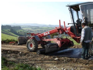
Pose du géotextile
